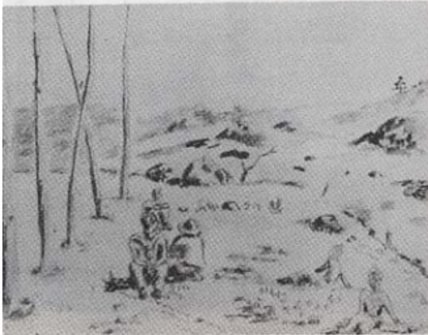
Clearing land at Roku Roshi
